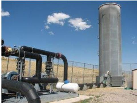
*Figura 11 Ejemplo de una antorcha de gas de LFG cerrada, del [sitio web de la EPA](#)*
